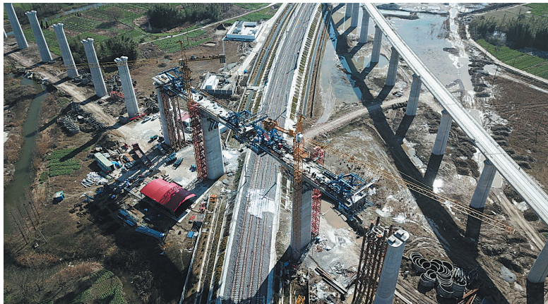
盐通铁路上行线跨沪通正线路基连续梁复工后率先施工。刘锡引
