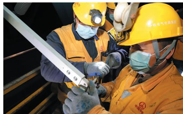
14日23时30分至15日凌晨5时10分,中铁电气化局施工人员在沪通长江大桥进行接触网导线架设。
