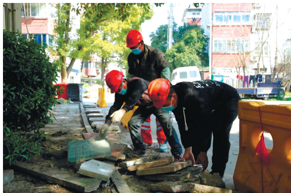
昨天,工人们正在进行城市道路无障碍设施施工。 汤建军
