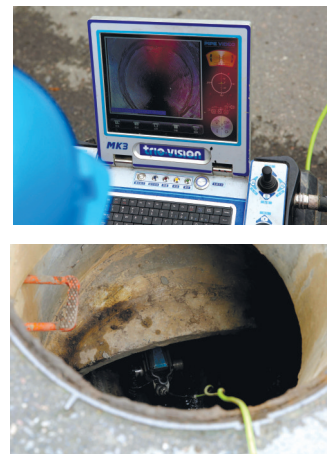
昨天,工作人员应用新一代数字高清型管道CCTV检测机器人现代技术手段,开展管网普查。记者尤炼
