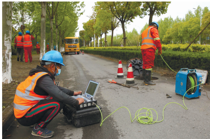
昨天,工作人员应用新一代数字高清型管道CCTV检测机器人现代技术手段,开展管网普查。记者尤炼
