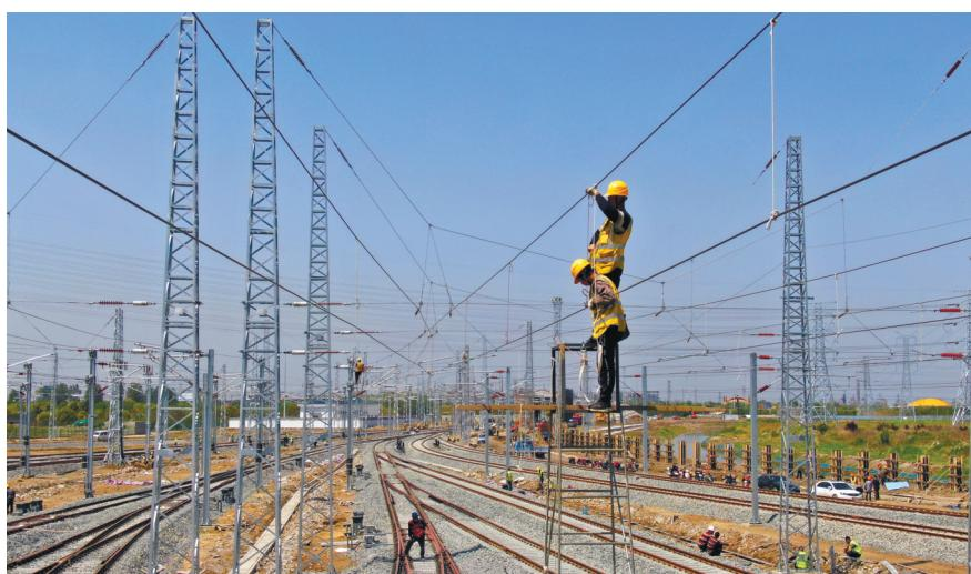
连日来,2000多名建设者奋战在存车线、检修库等项目工地上,南通动车所将于5月20日进行静态验收,待动态验收后将和通沪铁路同步开通。动车所即动车运用所,负责检查动车车辆状态,也就是动车“4S店”。图为昨天,施工人员在安装吊弦。
