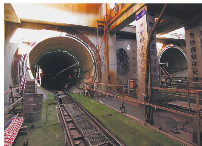
昨天,南通轨道交通1号线一期工程惠民路站至幸余路站区间双线顺利贯通,成为1号线一期工程首个双线贯通的长盾构区间。截至目前,1号线一期工程28个车站中已有24个车站完成主体结构封顶。累计投入盾构机31台次,31个单线区间贯通。记者蒋娇娇 尤炼 通讯员曹丹
