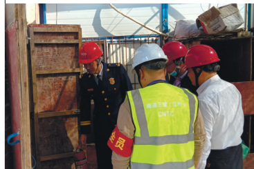
如皋消防联合多部门指导施工工地消防安全管理工作。尹颖
