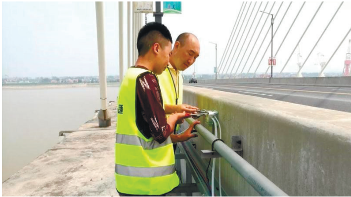
技术人员在通州东沙大桥安装二十四小时监测系统。(资料图片) 左蔚
