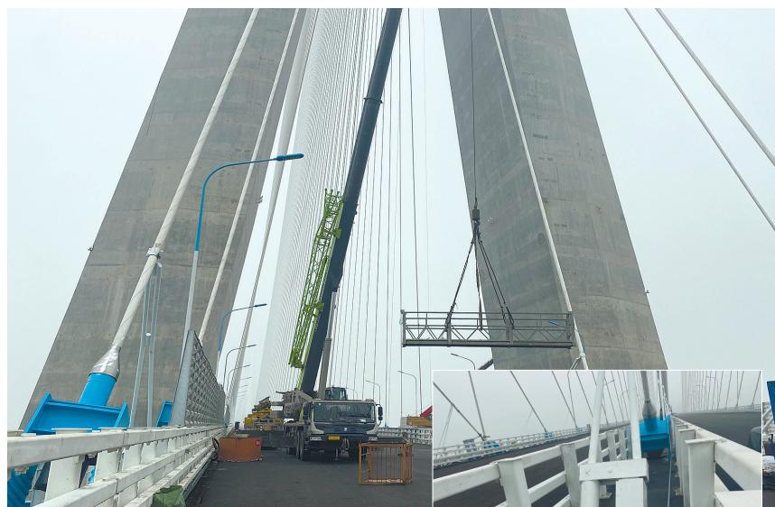
阻尼器的安装精度误差需要控制在1毫米以内。
