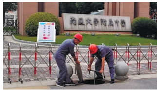
工作人员摸排考点周边的供水管线。
