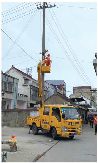
路灯安装。 洪绍敏 徐悦箫
