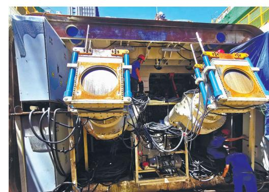
昨天上午,在世纪大道站附属结构1号口施工中,工人正在调试将要用于工农路过街通道施工的矩形顶管机。
