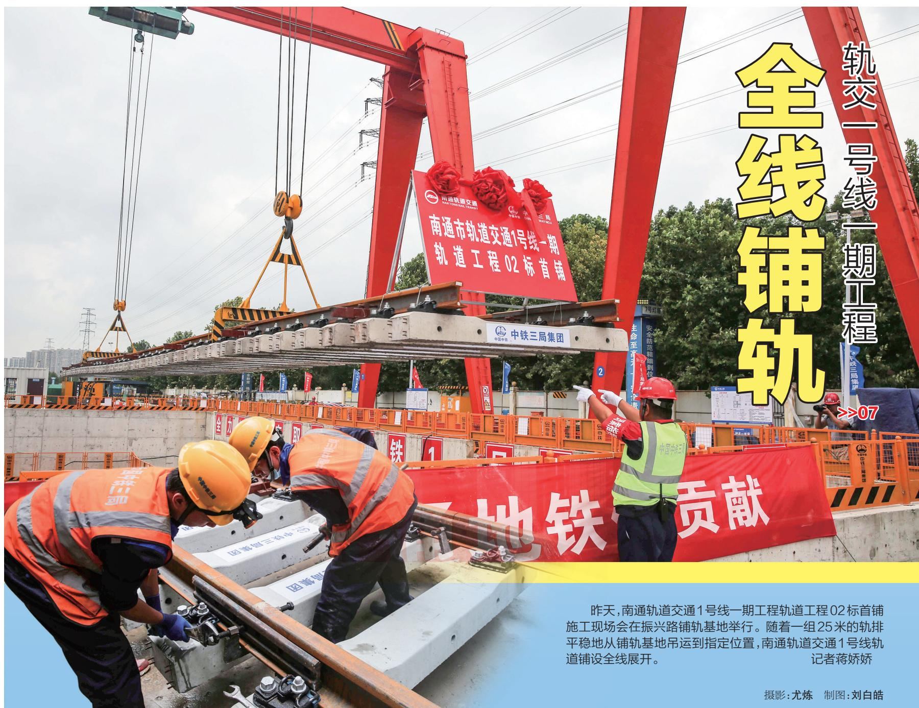
昨天,南通轨道交通1号线一期工程轨道工程02标首铺施工现场会在振兴路铺轨基地举行。随着一组25米的轨排平稳地从铺轨基地吊运到指定位置,南通轨道交通1号线轨道铺设全线展开。
