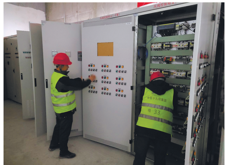
施工人员正在安装设备。轨道交通公司提供
