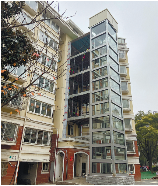
春晖花园23幢在建的电梯。见习记者张馨方
