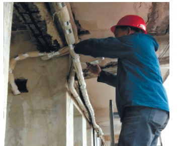
维修人员正在更换水管。
