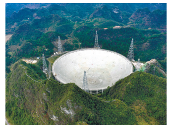
2020年1月11日拍摄的“中国天眼”全景(检修期间拍摄)。新华
