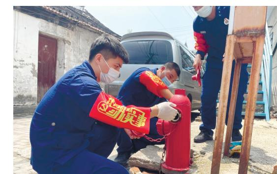
24日,和平桥街道濠阳社区联合濠河消防中队开展“找症结、办实事”专项行动,将街巷内破损生锈的消防栓涂抹黄油,并对破损缺失的水带等消防器材进行更换维修,累计维护消防栓、更换消防水带24处。
