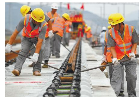
6月22日,中铁十一局的施工人员在杭绍台铁路上进行铺轨作业。当日,在杭绍台铁路温岭站施工现场,随着最后一根钢轨平稳在无砟道床上铺设到位,我国首条民营控股高铁杭绍台铁路全线铺轨贯通,为年底开通运营奠定基础。 新华
