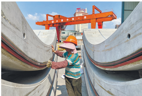
地铁体育公园站施工现场。记者黄哲
