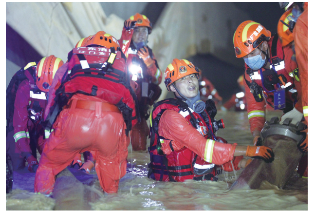
救援人员把排水设施向隧道深处推进。新华社
