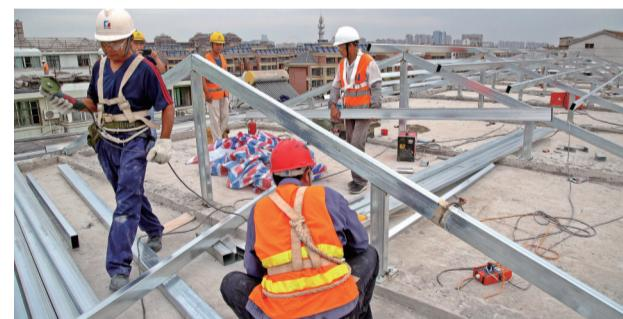
9日,施工人员在和平桥街道颐和社区万象北园老楼顶进行“平改坡”施工,彻底解决顶层住户雨天渗水、夏天闷热难题,受到居民交口称赞。 李斌
