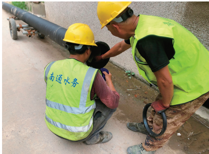
施工人员正在对新球墨铸铁管进行安装前准备工作。 记者俞慧娟
