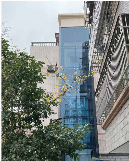
崇川区百花苑小区五十三幢加装的电梯。 记者李慧
