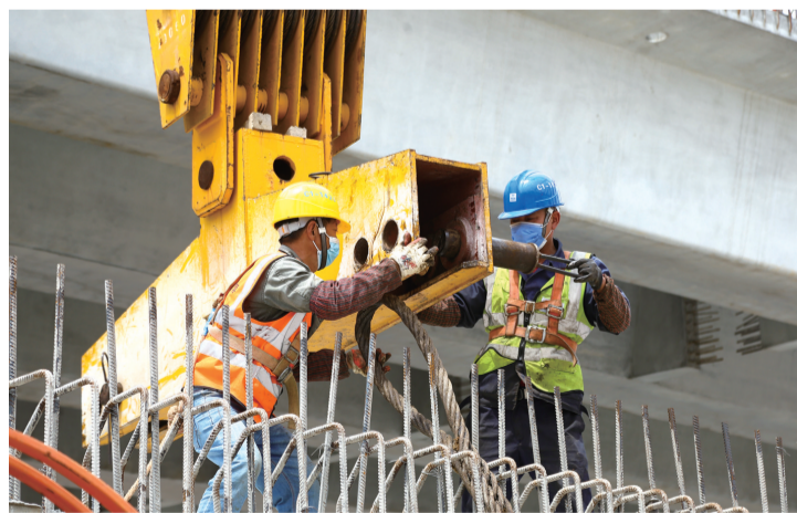
施工现场。 通讯员陈育
