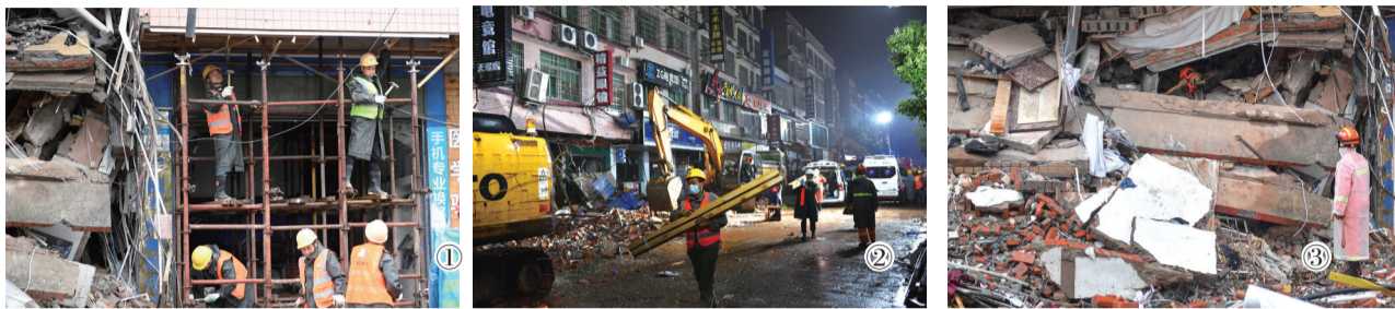
①在长沙居民自建房倒塌事故现场,救援人员紧急加固东西两侧受损严重、随时可能倒塌的房屋。②③救援人员带着搜救犬在现场进行救援。
