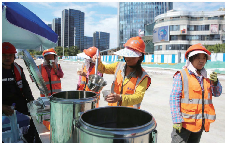
工农路改造现场,施工人员在休息时补充水分。记者尤炼
