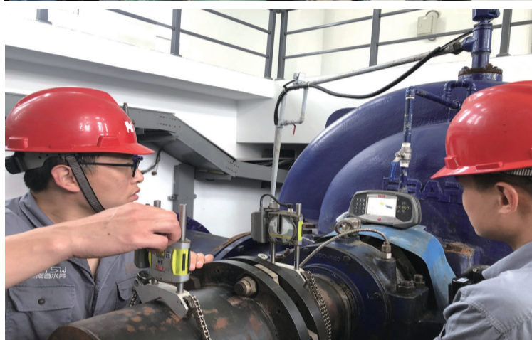
工作人员正在检修供水设备。记者俞慧娟
