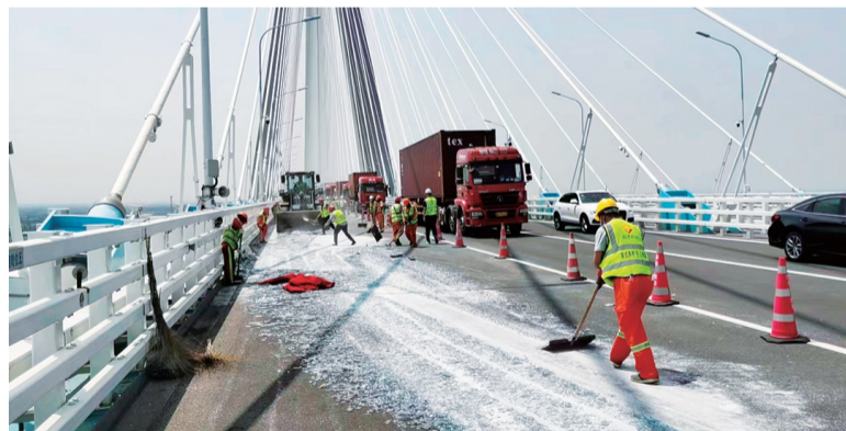
现场清扫玻璃碎片。
