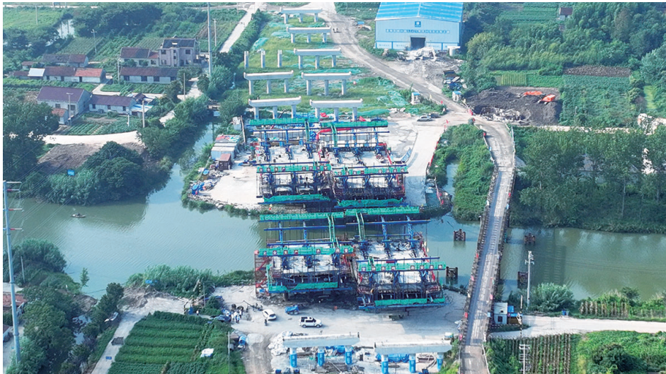
18日拍摄的南通绕城高速通启运河大桥施工现场。大桥全桥共70个节段,已完成22个节段,预计11月下旬贯通合龙。目前,南通绕城高速海门段已完成路基填筑54%、桥梁下部结构75%、板箱梁架设39%。 记者许丛军
