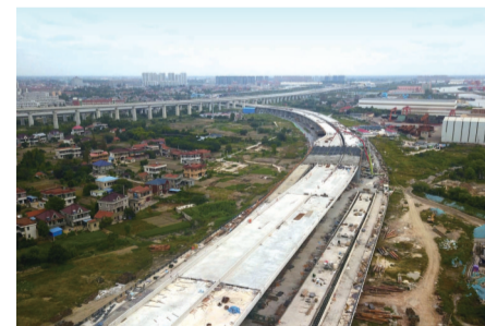
西站大道主线高架ZQ03联箱梁顶板顺利浇筑。
