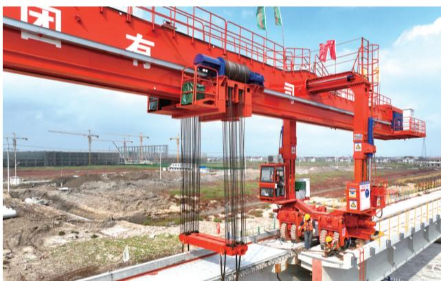
昨天,承担洋吕铁路2标制架梁及轨道施工的中铁十九局集团有限公司迎来重大节点,随着重达134吨的铁路混凝土T梁从架桥机腹部徐徐驶出,稳稳落在洋吕铁路2标遥望港特大桥桥墩垫石上,标志着洋吕铁路建设进入新征程。记者许丛军
