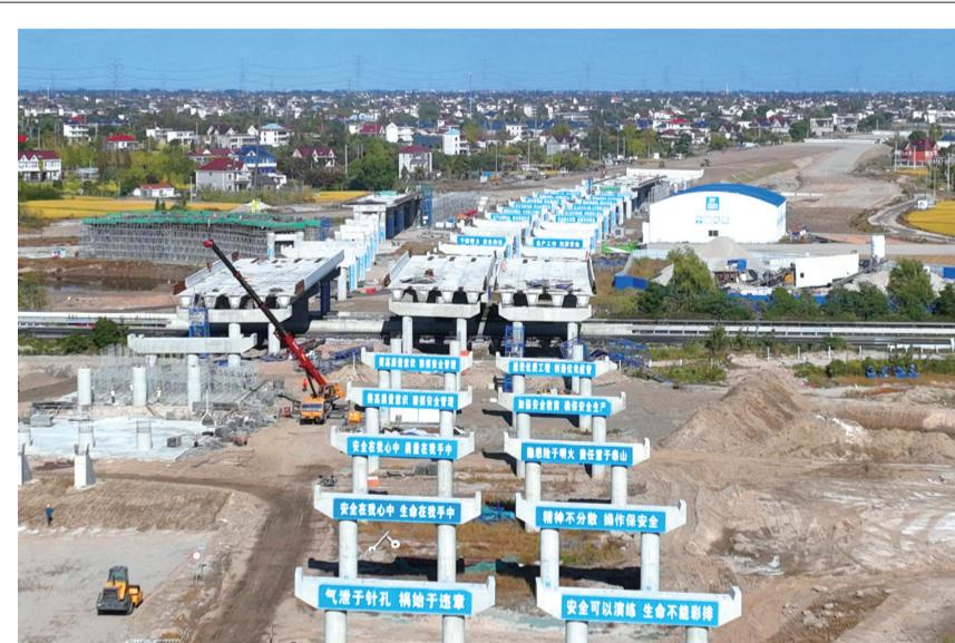
昨天,南通绕城高速LJ3工区项目新联枢纽正在施工。截至目前,新联枢纽快速安全推进,路基填筑和桥梁下部构造已经完成70%,完成主线及匝道3次跨越G15施工,年内将按计划完成第一步交通导改及E匝道跨沈海高速钢箱梁顶推施工。南通绕城高速(S19)在投融资、“建管养营一体化”、施工总承包、装配化生产方式等方面全面创新。由南通交投集团负责项目投融资和建设管理的南通绕城高速是江苏省首条引入社会资本投资的高速公路项目。
