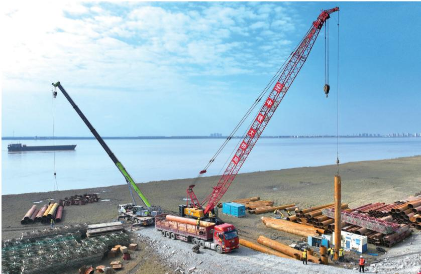
昨天在启东市拍摄的北沿江高铁崇启公铁大桥栈桥钢管桩插打现场。23日,首根钢管桩成功插打,标志着崇启公铁大桥栈桥施工正式拉开序幕。
