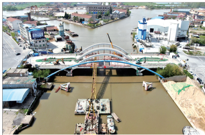
大洋港桥拆除作业
