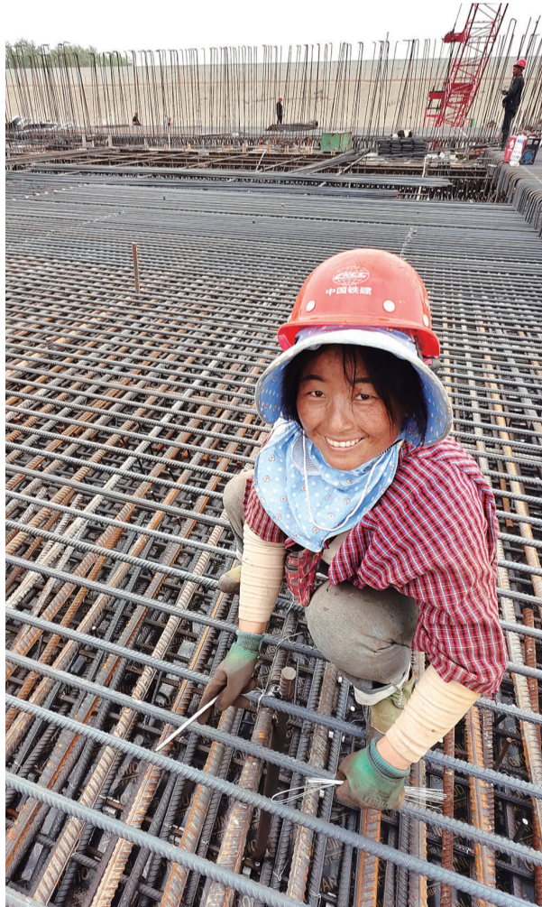
▲绑扎 4月19日,绕城高速建设工地,绑扎钢筋的工人。朱健
