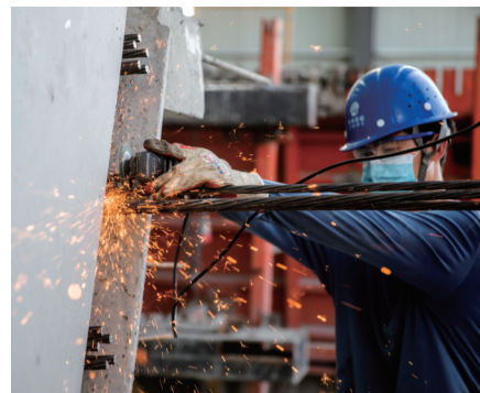
▲切割 4月17日,洋通高速公路建设工地,一名工人在切割钢缆。顾炳泉
