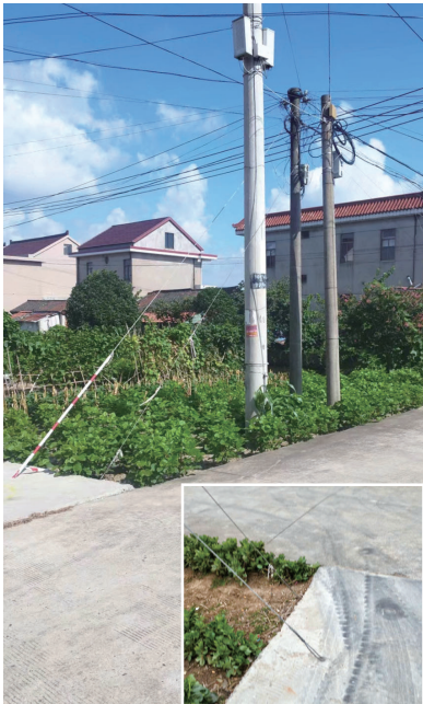
路面上的两根用于固定电信发射杆的桩线。
