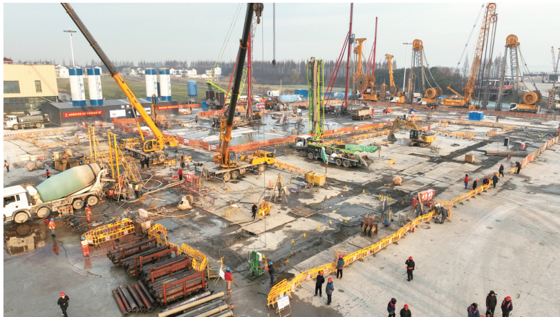
随着最后一幅钢筋笼槽段浇筑完成,张靖皋长江大桥南航道桥南锚碇基础地连墙施工完成。 彭军君 张正培
