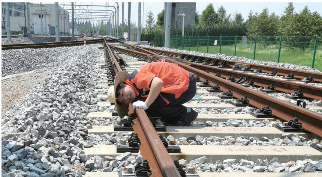
肖路路利用目视对绝缘接头轨缝进行检查。 记者汪小林
