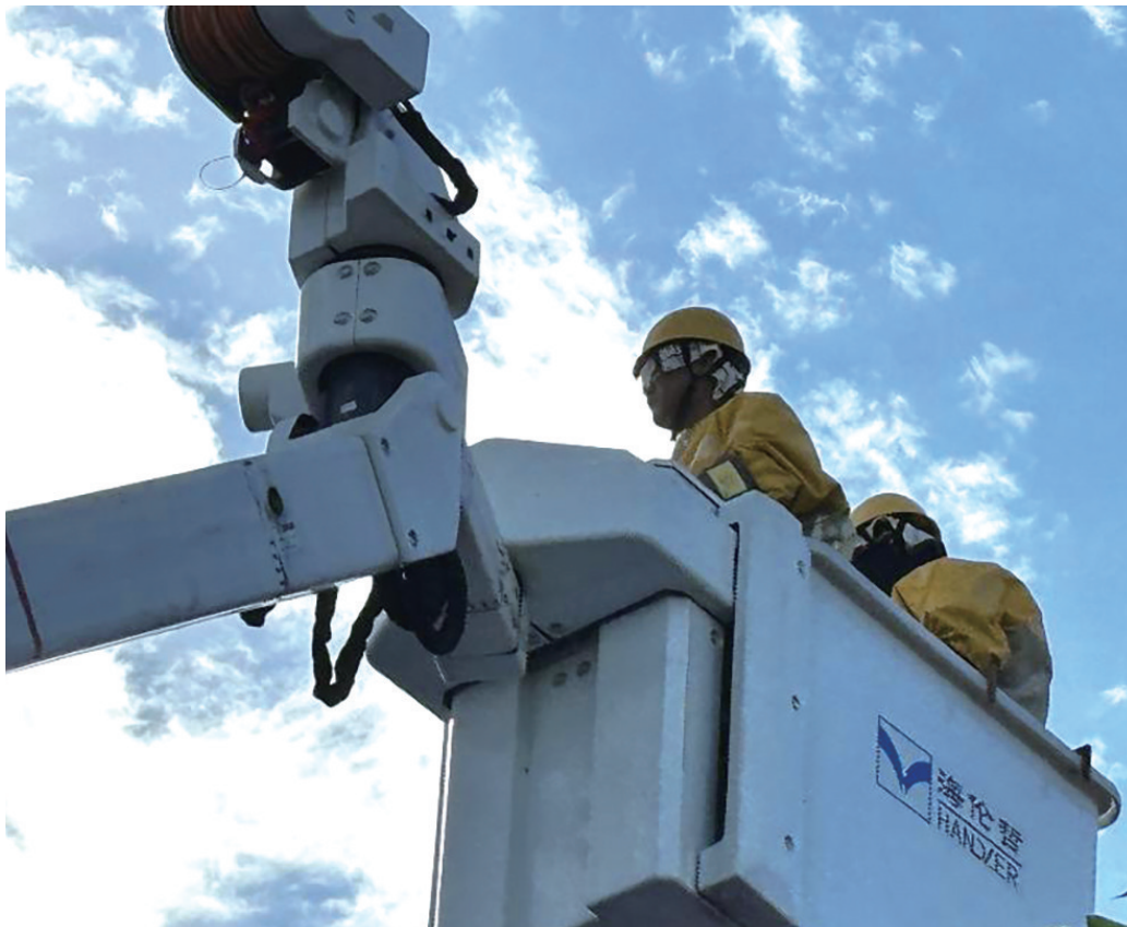
电力工人在绝缘斗臂车中实施高空作业。
