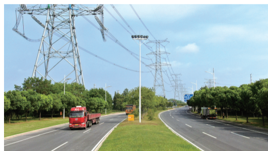
东方大道提升改造工程提前完工。记者尤炼
