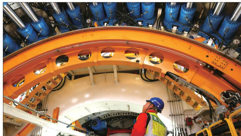
昨天，中铁十四局集团海太长江隧道项目顺利完成盾构首环负环管片整体定位拼装，为隧道正环拼装提供了条件。此次“江海号”盾构首环负环管片定位拼装工作的完成，保证了项目盾构施工目标的进一步推进，为盾构始发掘进工作提供必要条件。
