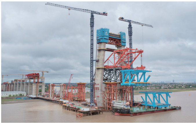
沪渝蓉 高铁崇启公 铁长江大桥 主通航孔桥 4号墩首节 钢梁吊装施 工现场。 记者许丛军
