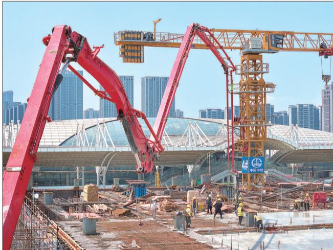
7月6日,由中铁建工集团承建的北沿江高铁(新建上海至南京至合肥高速铁路)南通站新建站房高架层B1区混凝土浇筑顺利完成,浇筑面积约2116平方米,一次性混凝土浇筑量达1680立方米,标志着高架层区域主体结构施工驶入“快车道”,为后续站房建设按下“加速键”。 记者许从军
