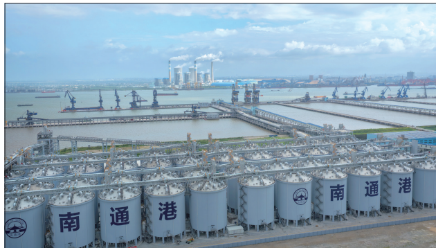
昨天拍摄的南通港天生港区横港沙作业区10万吨级粮油码头一角。近日通过竣工验收的粮油码头投运后可接靠进口粮食、内贸粮食的主力船型,食用油年吞吐量可达80万吨,并可依托二线5000吨级泊位提供方便快捷的中转运输。
