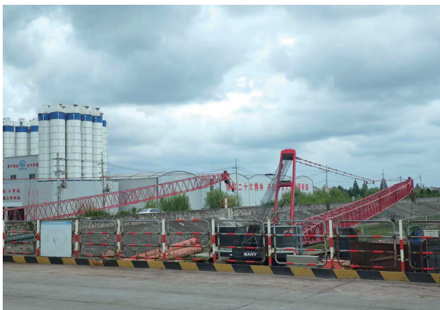
崇启公铁长江大桥项目启动应急预案,全面落实防风加固措施。图为放倒的吊机。李梦竹
