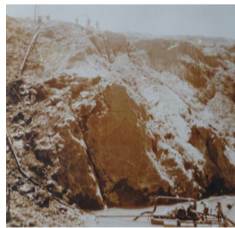
水力挖土用于水闸建设工地
