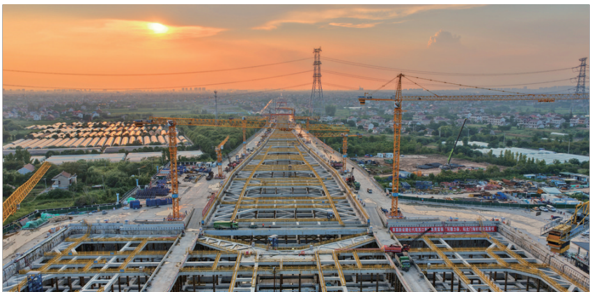
昨天拍摄的海门北站施工现场。我国目前最长的超深、超大基坑地下高铁站——海门北站建设全面转入主体结构施工阶段,主体结构计划于2026年3月完成。 记者许丛军
