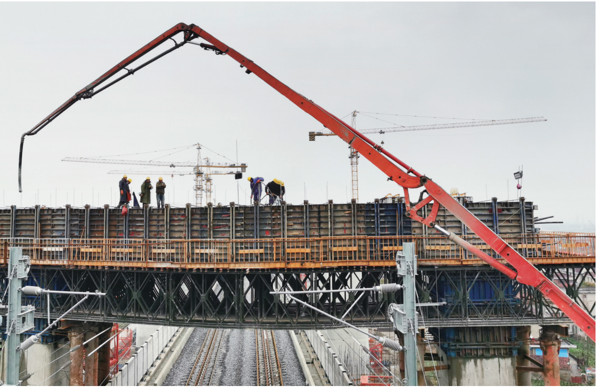
11日下午,由中铁二十四局集团承建的盐通铁路通张段长江大桥北引桥55号门式墩盖梁浇筑完成,标志着通张铁路跨沪通铁路门式墩节点目标顺利完成。据悉,新建盐城至南通铁路南通西至张家港段同步实施工程作为盐通铁路的延长段,正线全长约24.3公里,分为2个标段。该铁路建成之后将衔接盐通铁路与苏南沿江铁路,有效缩短苏北地区与长三角地区距离。 记者 彭军君摄
