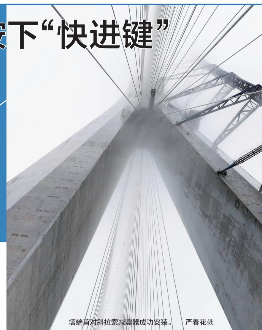
塔端首对斜拉索减震器成功安装。严春花摄
