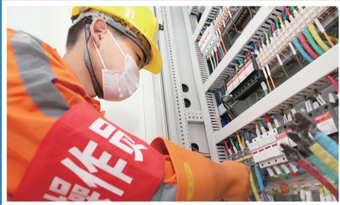
昨天,沪通铁路首座10kV配电所受电启动,中铁电气化局操作员进行交流盘进线验电。许从军摄
