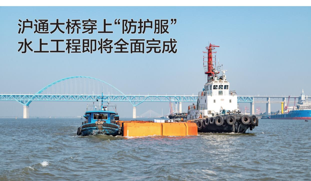
本报讯 (记者彭军君 通讯员王健达 陈超 郑林)昨天早晨7时许,沪通长江大桥26#墩防撞设施首部节段,从南通蛟龙重工码头起运,在南通、张家港两地海事部门交通组织和现场3艘海巡艇的维护下,通过拖船拖带缓缓驶向安装现场。未来25天里,沪通长江大桥26#至31#桥墩的六套防撞设施共计28节段将通过28航次,每个航次拖运1个节段分别运至安装现场。随着防护设施的逐步安装完成,将为大桥穿好一件坚固“防护服”,同时标志着沪通长江大桥水上工程即将全面完成。
